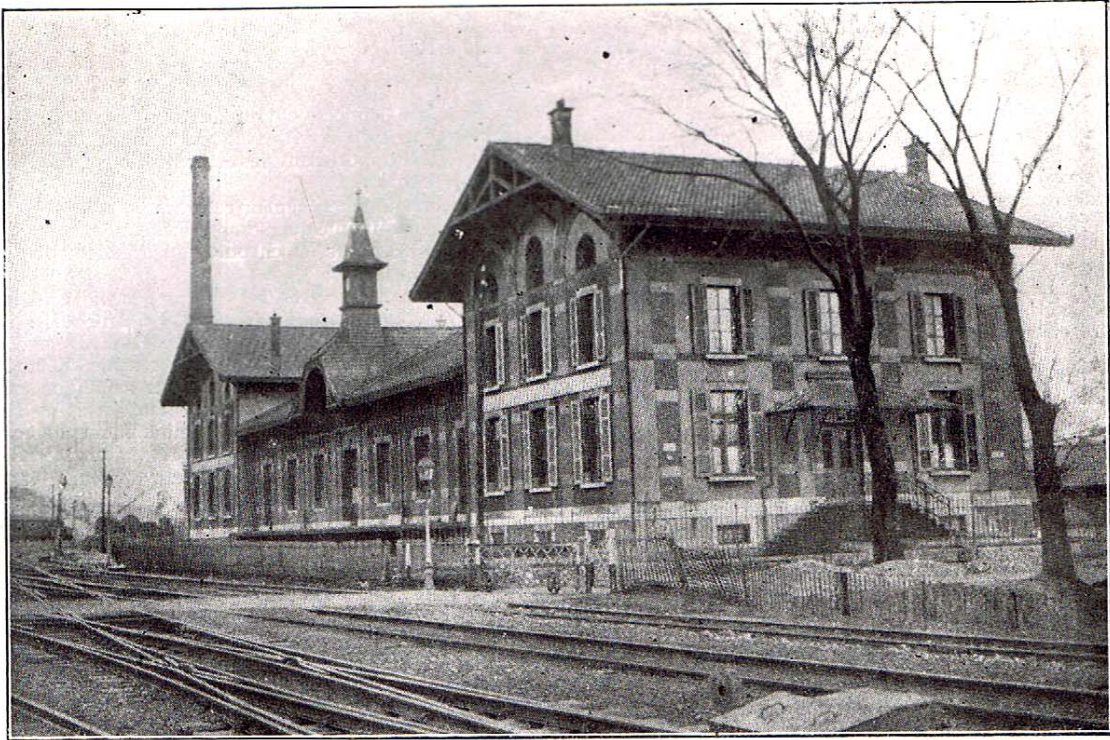
VUE DES ÉTABLISSEMENTS DE PONTARLIER
